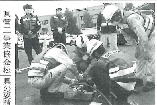
水道管漏水箇所の応急復旧に当たる会員＝松江市内
