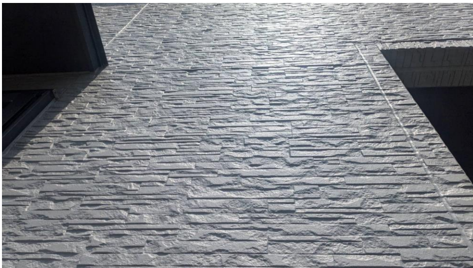
アミコート塗装後の外壁
